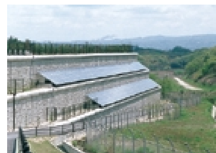
2号擁壁太陽電池39kW
