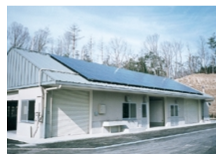
作業棟太陽電池11kW
