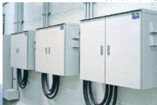
10kWユニットインバータ×3台
