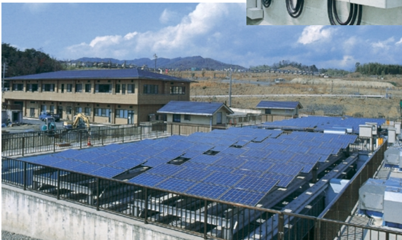
太陽電池設置状況（京都府乙訓浄水場）
