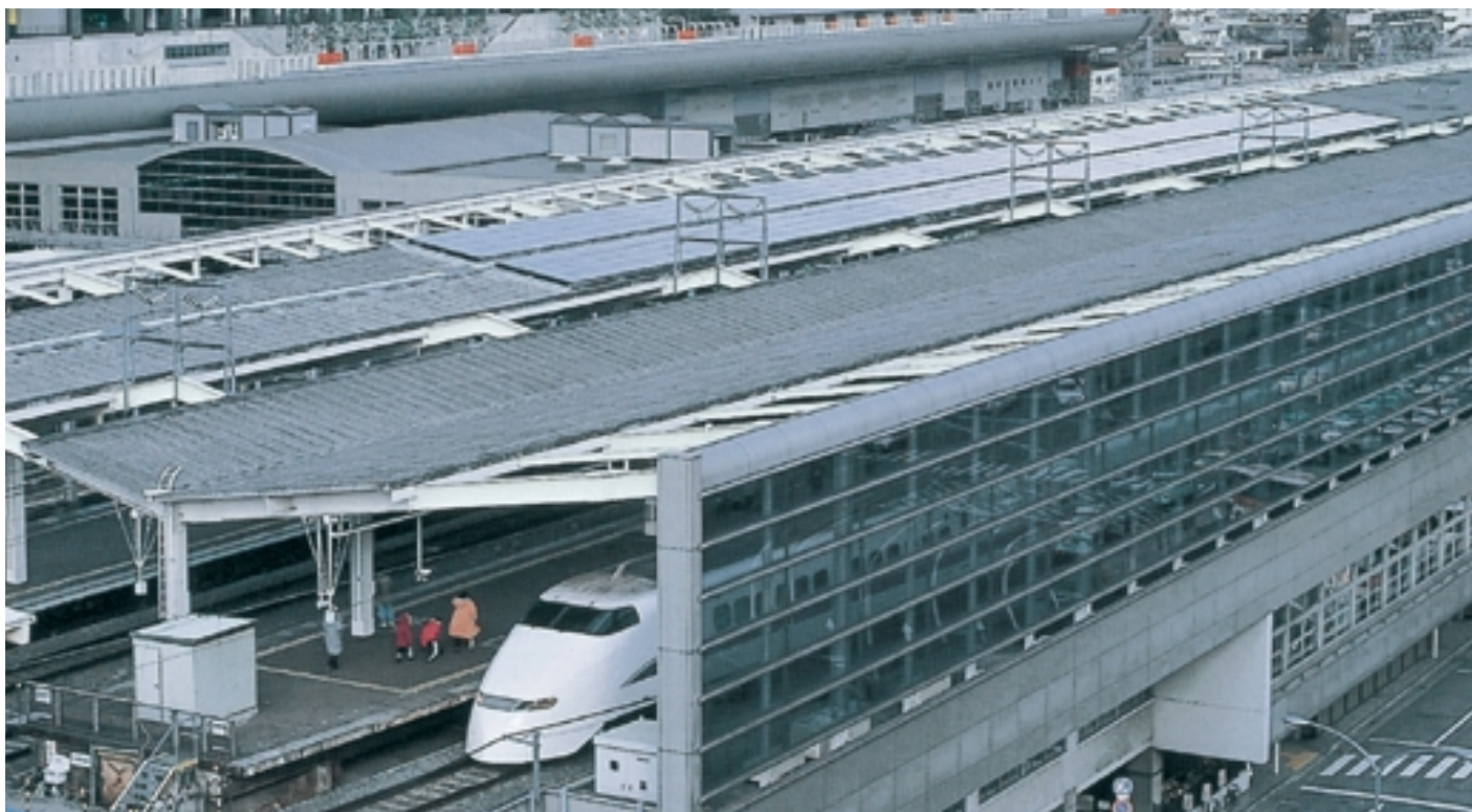
太陽電池設置状況
