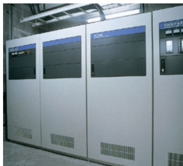
100kW系統連系装置
