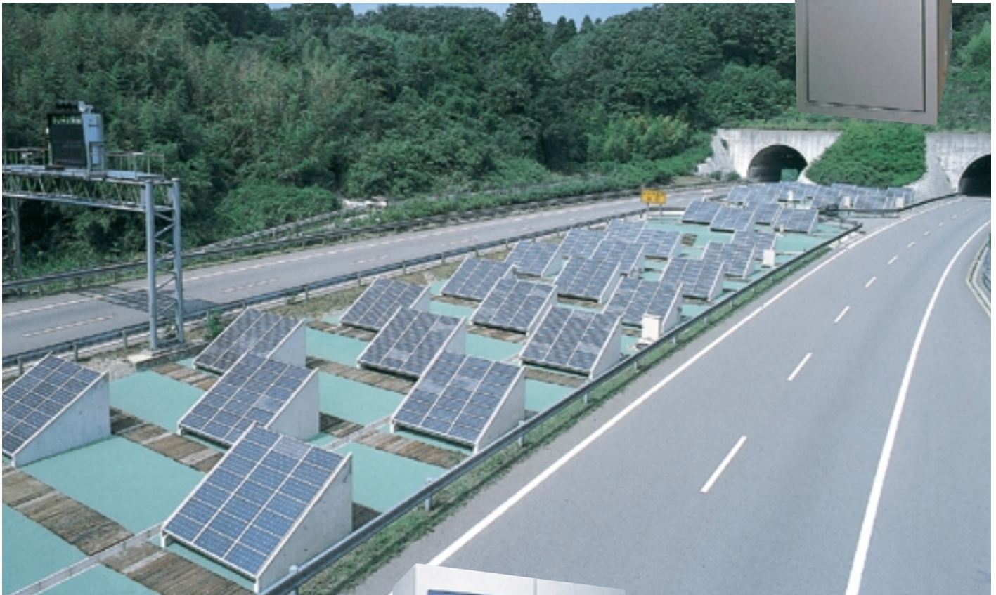
太陽電池設置状況
