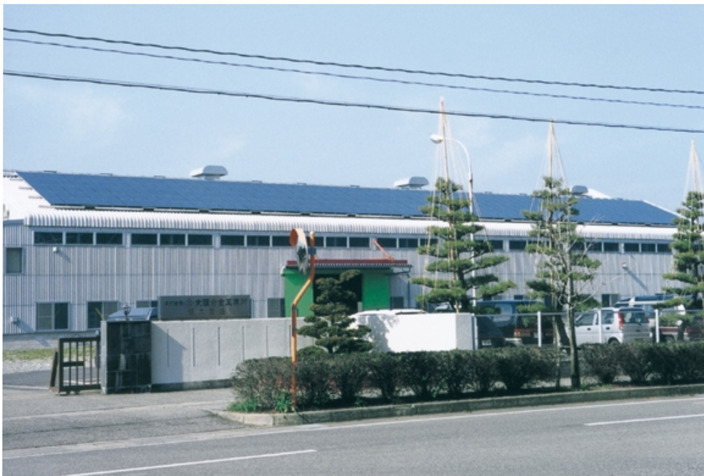
工場の屋根全面にシステムが設置されている
