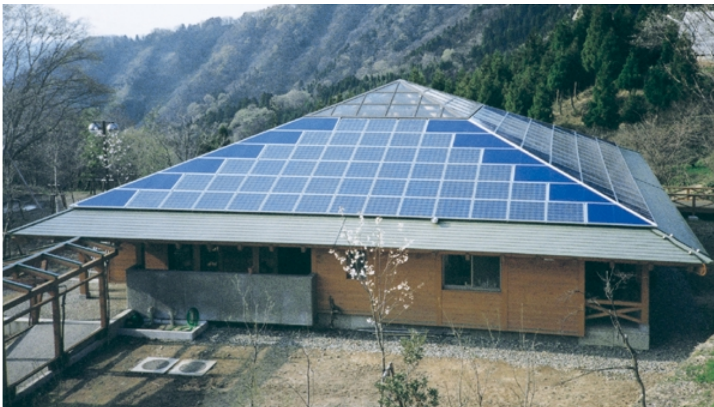
太陽電池は方形型屋根（傾斜角：約20度）の四面に設置されている。
